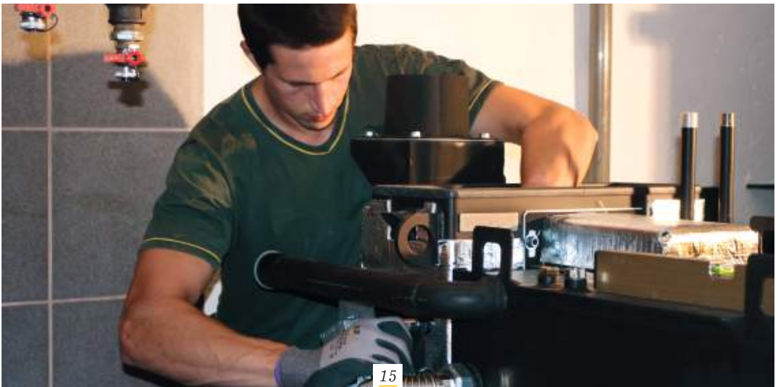
KWB Classicfire – pannan kan demonteras i tre delar.
